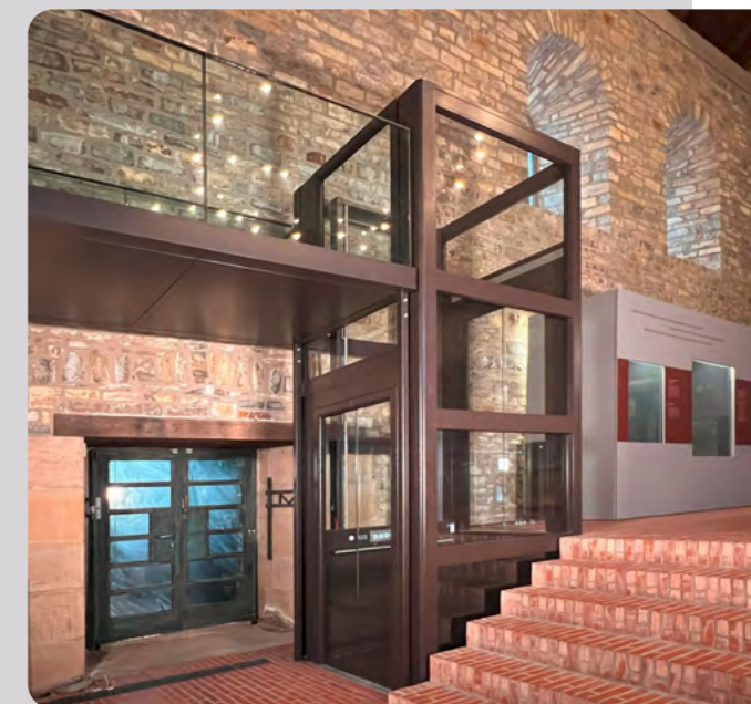
Typisch Ganser: maximale Unabhängigkeit durch selbststehenden Schacht.
